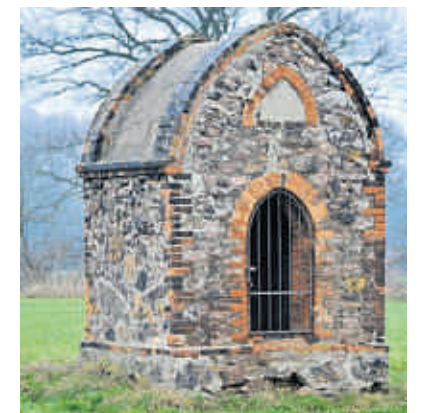
Das Pulverhäuschen bei Jeßnitz
