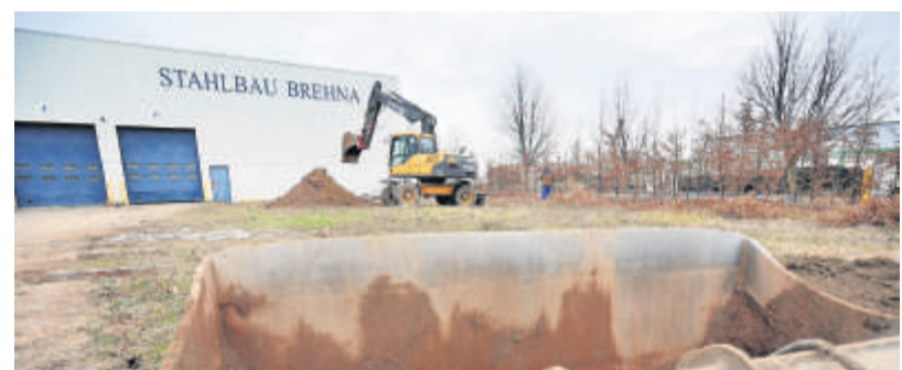
Gestern begannen die Bagger mit den Erdarbeiten.
